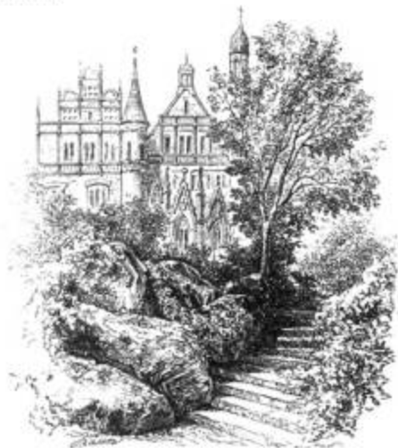
Часть южнаго фасада замка съ церковью.
